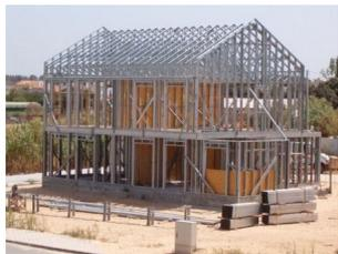
A Central Projectos desenvolveu recentemente um projeto de estruturas recorrendo ao sistema *Light Steel Framming*. O projeto, solicitado pelo cliente *Cool Heaven*, visa a construção de um edifício de habitação de três pisos e reforça a versatilidade e capacidade de resposta da empresa às diversas solicitações dos seus clientes.
